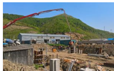
РЕКОНСТРУКЦИЯ ОЧИСТНЫХ СООРУЖЕНИЙ НА Р. МАЛКА г. Холмск
