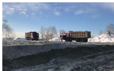
СТРОИТЕЛЬСТВО ОЧИСТНЫХ СООРУЖЕНИЙ п/р Ново-Александровск
