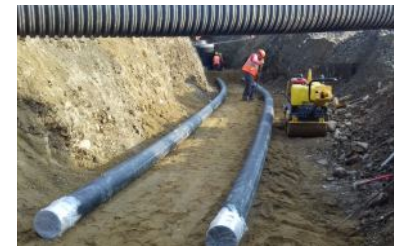
СТРОИТЕЛЬСТВО АЭРОВОЗЯЛЬНОГО КОМПЛЕКСА Южно-Сахалинск
