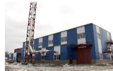
СТРОИТЕЛЬСТВО КОТЕЛЬНОЙ с. Восток
